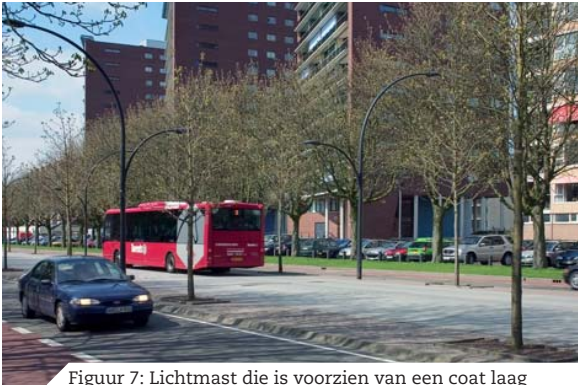
Figuur 7: Lichtmast die is voorzien van een coat laag
